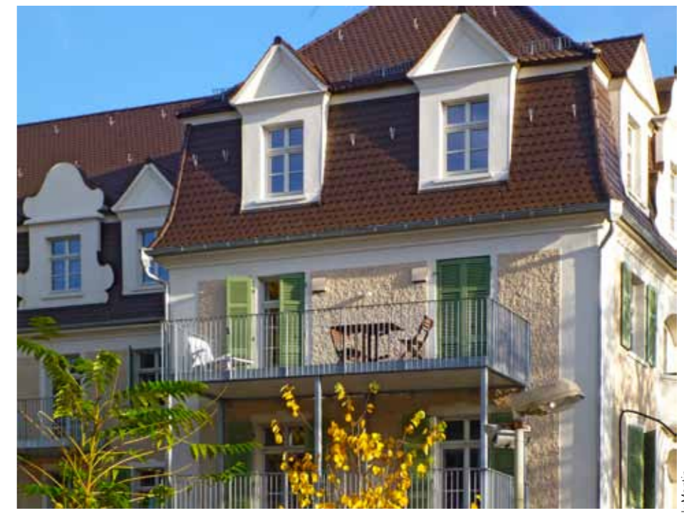
Die Wohnanlage „Neue Hofgärten“ in Ludwigshafen wurde für die gelungene energetische Sanierung ausgezeichnet
