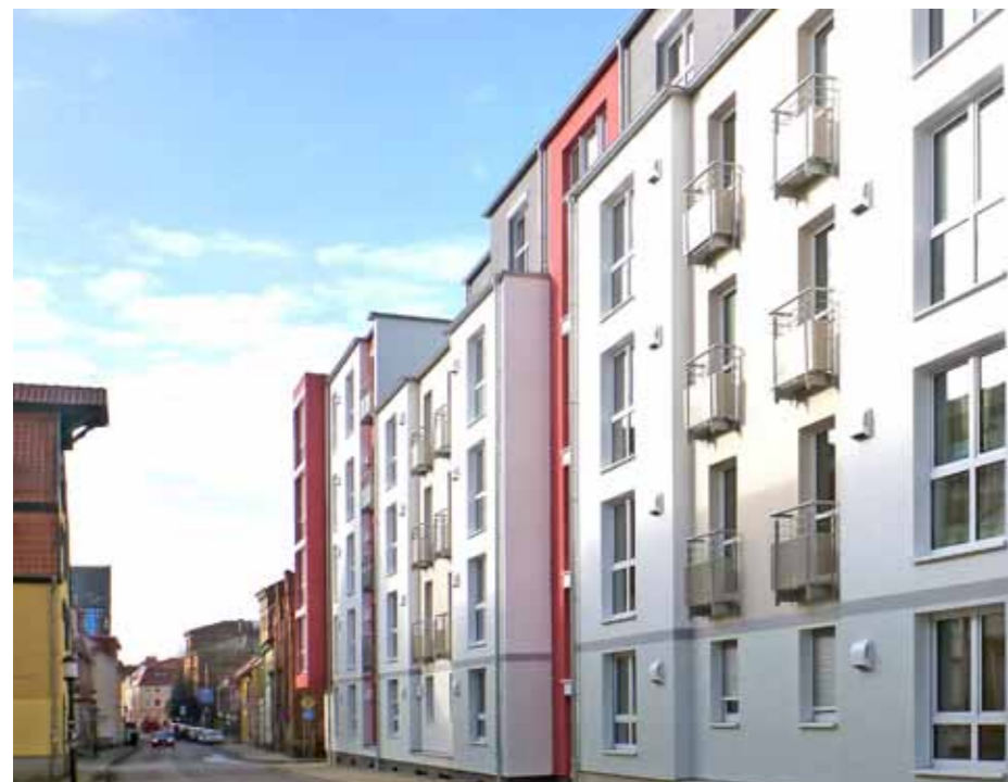
Der Einsatz dezentraler Lüftungssysteme im Geschosswohnungsbau bietet erhebliche Kostenvorteile und gewährleistet ein angenehmes Raumklima, hier das Objekt an der Friedrich-Loeffler-Straße in Greifswald
